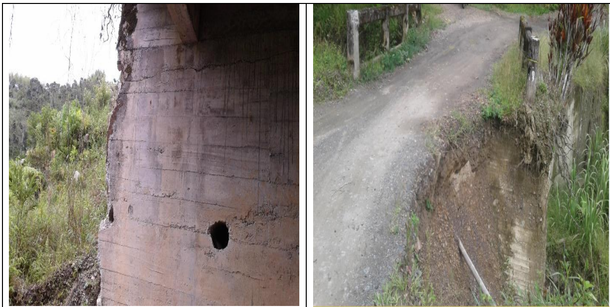
Fotos: Puente sobre la Quebrada El Cedrón el cual presenta averías severas, consistentes en fallas estructurales en los estribos y aletas de la infraestructura del puente.
