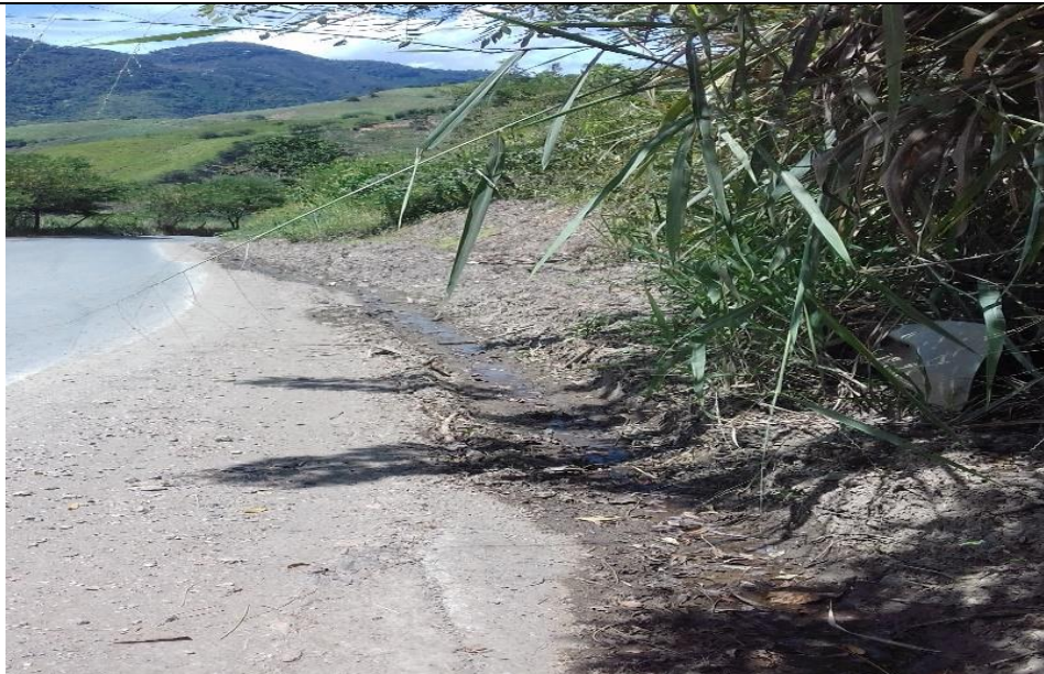
Foto 1. Cunetas del talud intervenido en el fallo 2 taponadas. Foto tomada por el auditor. 27/08/2018.
