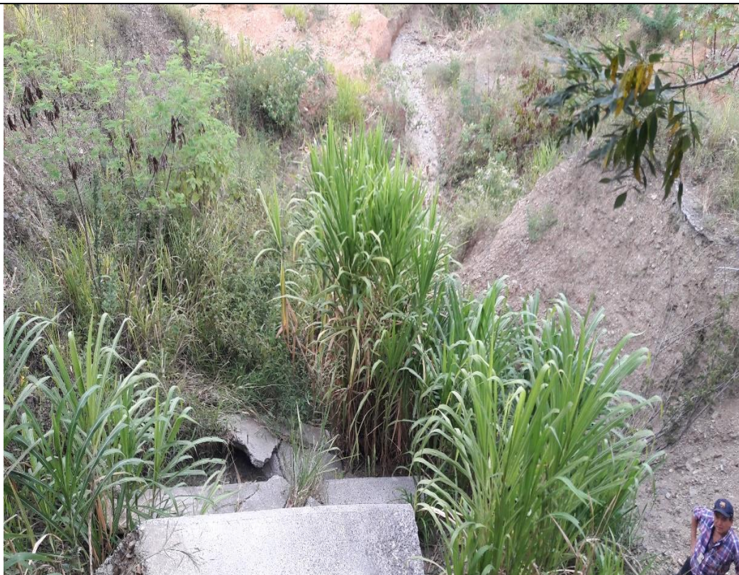
Fotografía 5. Vista General desde arriba del colapso de los gaviones revestidos a la entrega del canal de sacos del fallo 2. Foto tomada por el auditor el 27/08/2018.
