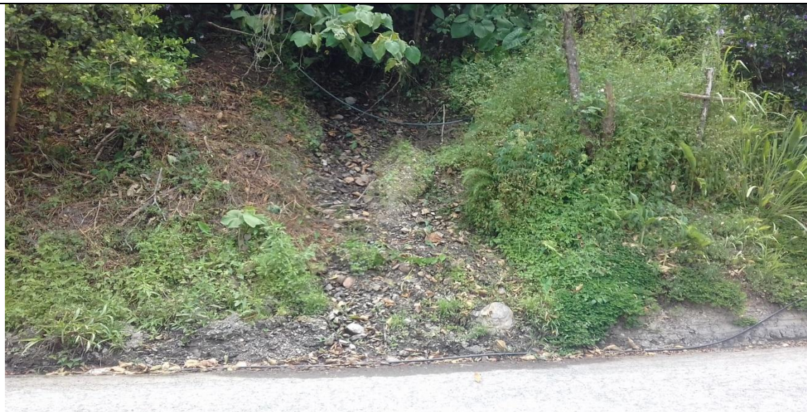
Foto 5. Cunetas del talud intervenido en el fallo 8 taponadas. Foto tomada por el auditor., 27/08/2018.
