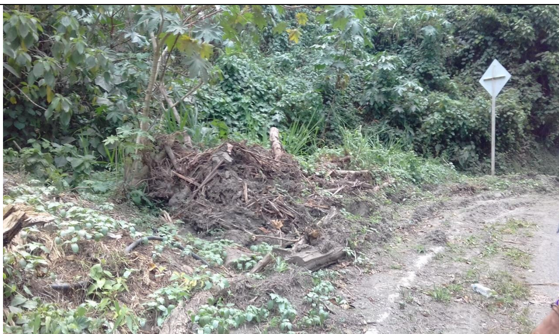
Foto 6. Cunetas del talud intervenido en el fallo 8 totalmente taponadas. Foto tomada por el auditor., 27/08/2018.
