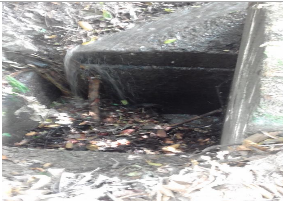
Foto 4. Cunetas del talud intervenido en el fallo 8 taponadas. Foto tomada por el auditor., 27/08/2018.
