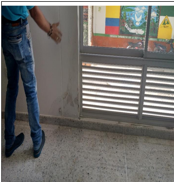
Fotos situaciones anómalas: Humedades en sala de profesores en el bloque occidental.
