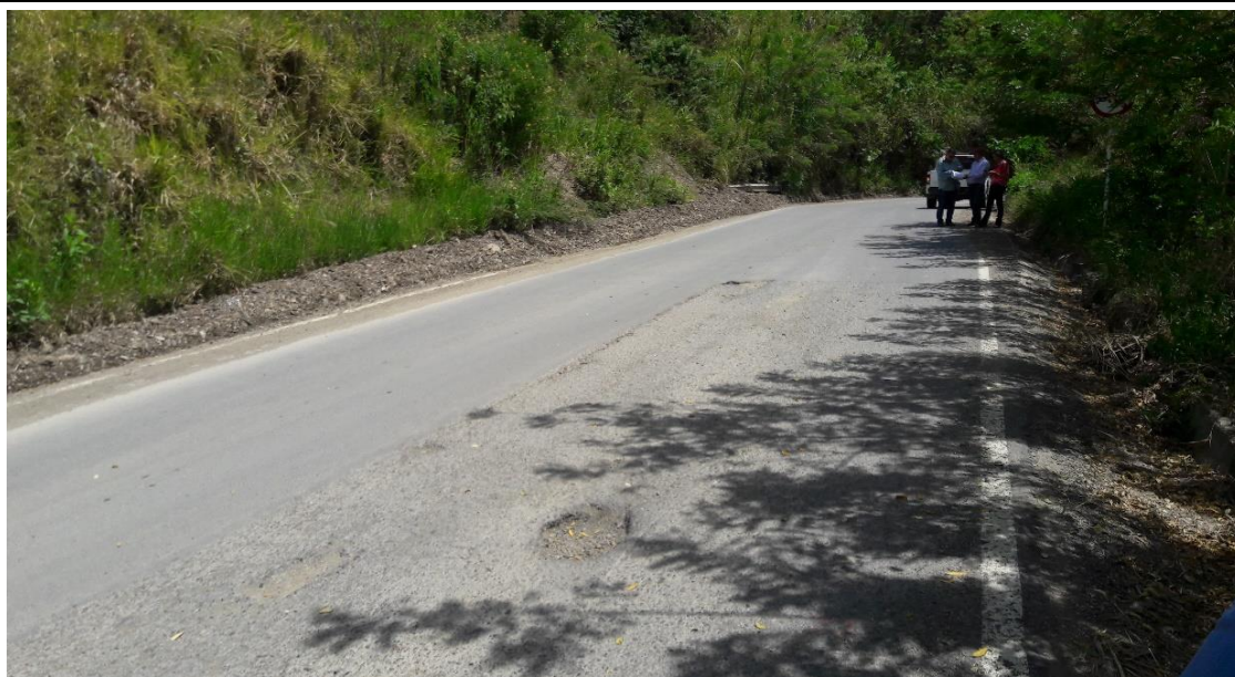
Foto 2. Cunetas del talud intervenido en el fallo 8 totalmente taponadas. Foto tomada por el auditor., 27/08/2018.
