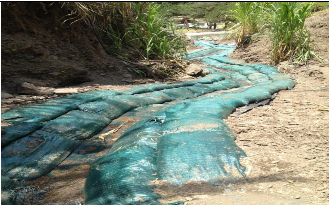
Fotografía 1. Vista general de la construcción de los gaviones revestidos a la entrega final del canal de sacos del fallo 2. Foto suministrada por la entidad territorial.
