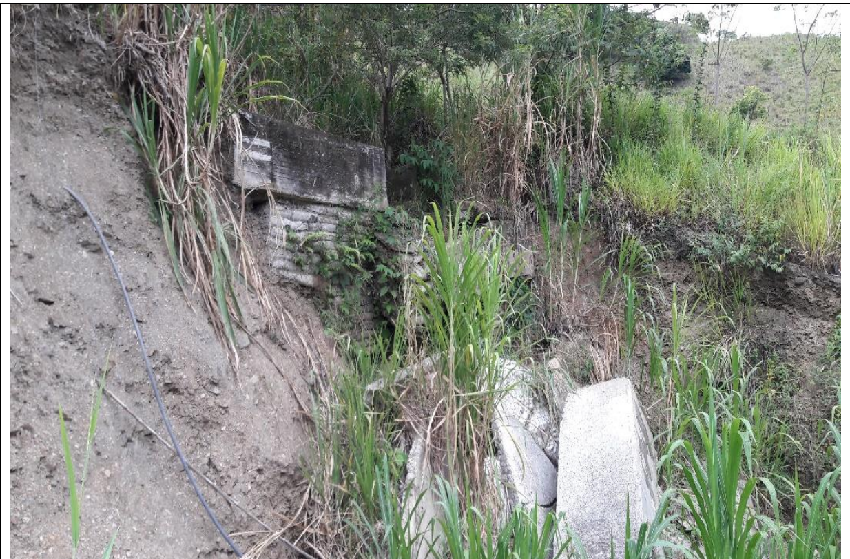
Fotografía 4. Vista general desde abajo del colapso de los gaviones revestidos a la entrega del canal de sacos del fallo 2. Foto tomada por el auditor el 27/08/2018.
