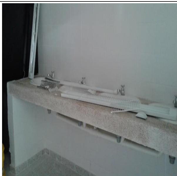
Fotos situaciones anómalas: Lámparas de iluminación de los baños desmontadas sin funcionamiento.
