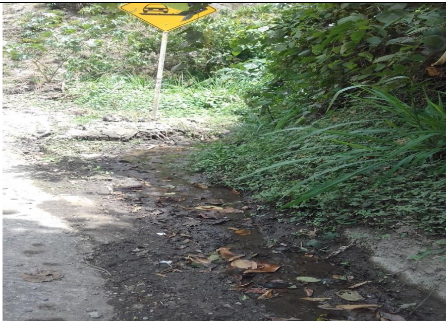
Foto 3. Cunetas del talud intervenido en el fallo 8 taponadas. Foto tomada por el auditor., 27/08/2018.
