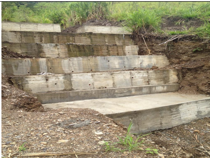
Fotografía 2. Vista general de la construcción los gaviones revestidos a la entrega final del canal de sacos del fallo 2. Foto suministrada por la entidad territorial.
